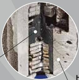
Нет дренажной полости, вода попадает в корпус замка
